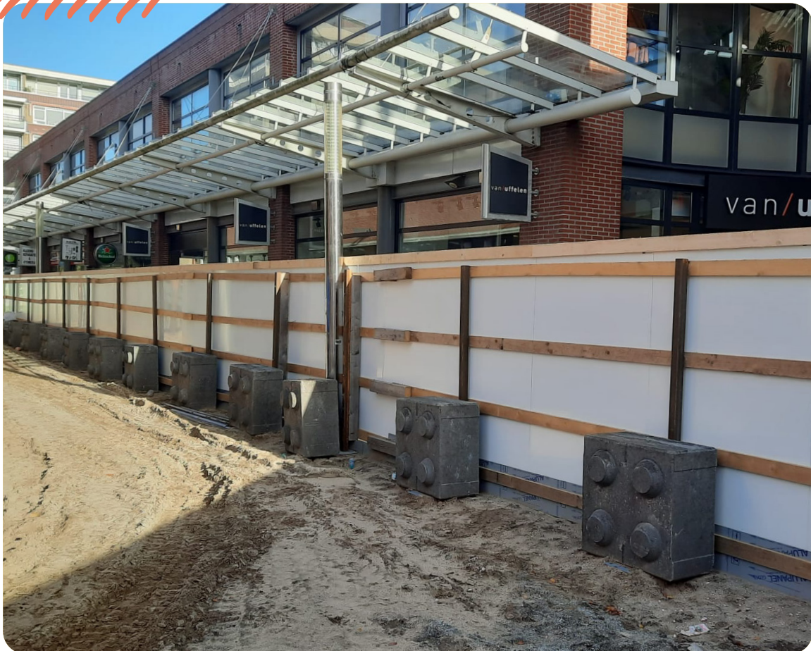
PLAATSING MET BALLASTBLOKKEN
